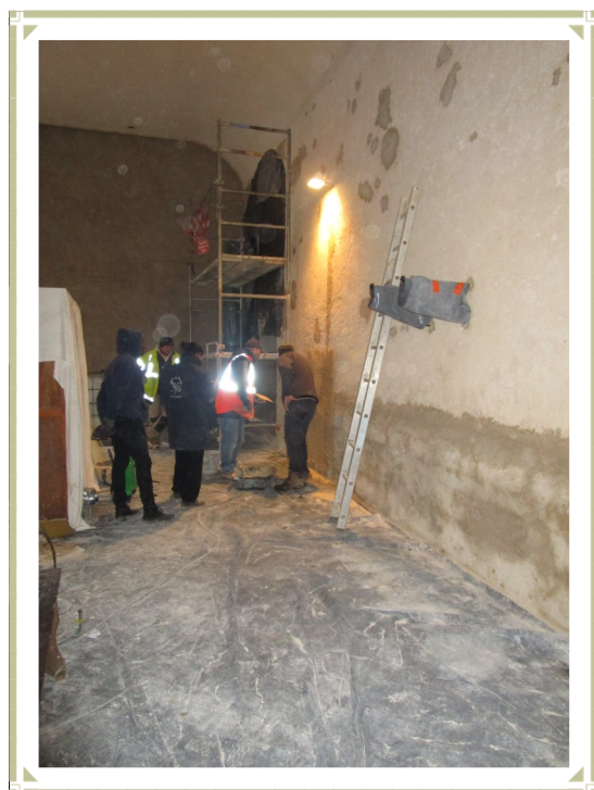
Chantier de l'église en cours, les travaux sont réalisés par le Club Marpen
